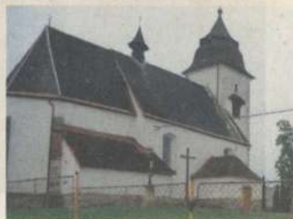
OPRAVY. Kostel Nanebevzetí Panny Marie v Číhošti potřebuje opravu tarasu, který stavěl už páter Toufar. Foto: Věra Kovandová
